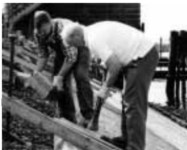
„Stackwerker“ beseitigen Schäden am Deich
